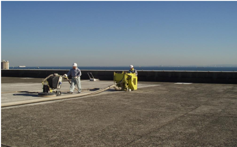
切削機と研磨機による劣化コンクリート表層除去研磨 工事風景
