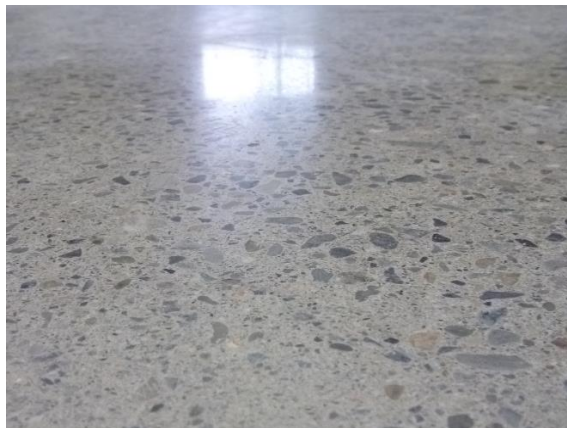
削り深さ 2 mm 研ぎ出し鏡面仕上げ
