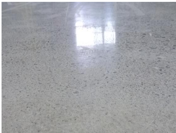
削り深さ 1 mm 研ぎ出し鏡面仕上げ
