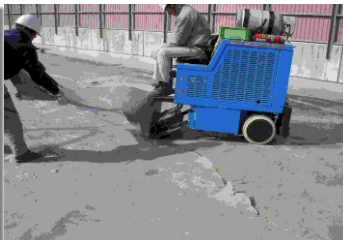
屋上防水材除去
