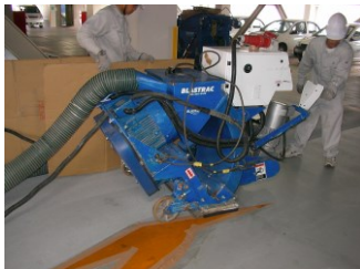
コンクリート表面目粗し
