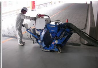
駐車場 ノンスリップ処理
