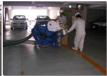
コンクリート スロープ目粗し
