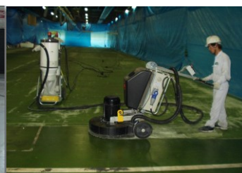
樹脂モルタル表面研磨目粗し
